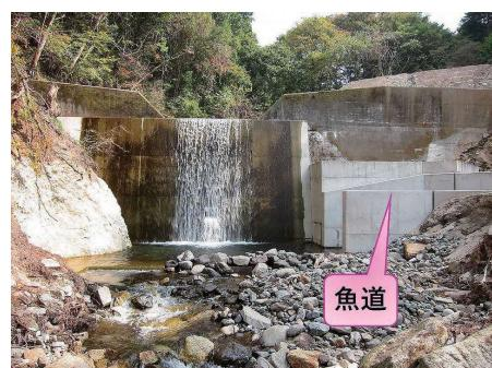
図1 不透過型堰堤と魚道
