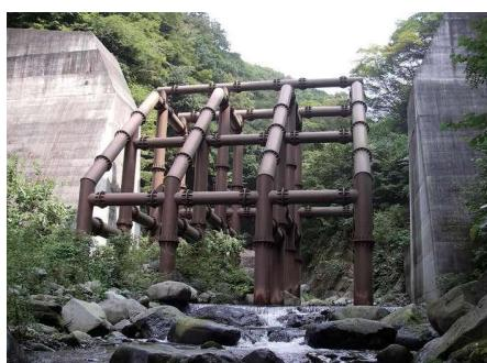
図2 透過型堰堤（鋼製スリット格子棒型）
