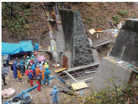
図3 治山堰堤のスリット化改修現場
